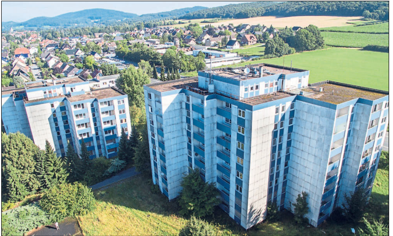
84 Wohnungen stehen in den beiden Hochhäusern am Sandkamp seit 2007 leer. Am Ortseingang von Halle entwickeln sich die herunterge-
